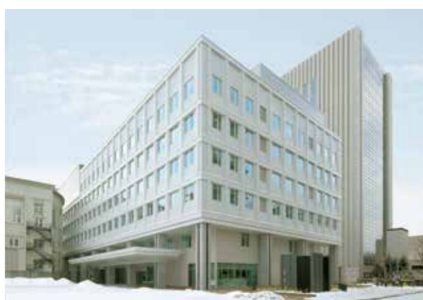
▲ 北海道議会庁舎改築その他工事(2工区)
