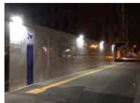
仮囲いに夜間照明を設置し 歩行者の安全を確保
